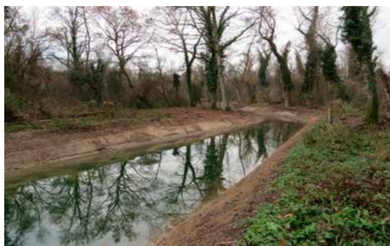
Chenal finalisé, avant les premières mises en eau
