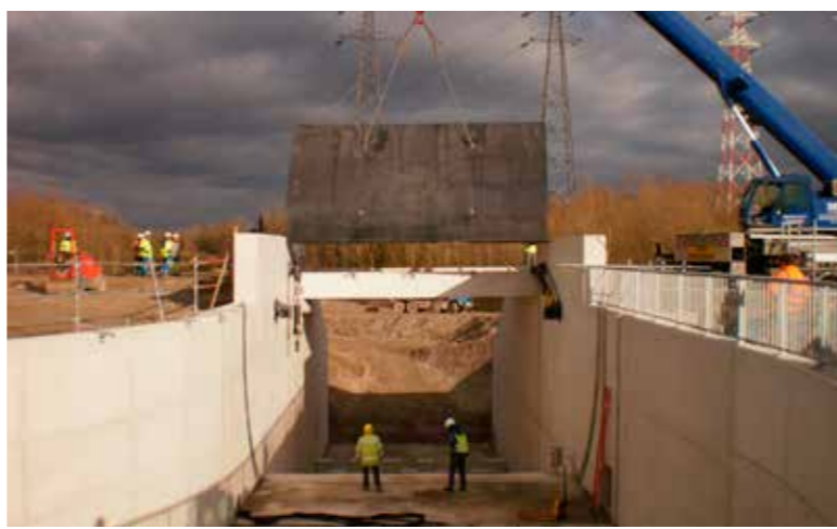
Mise en place de la vanne
