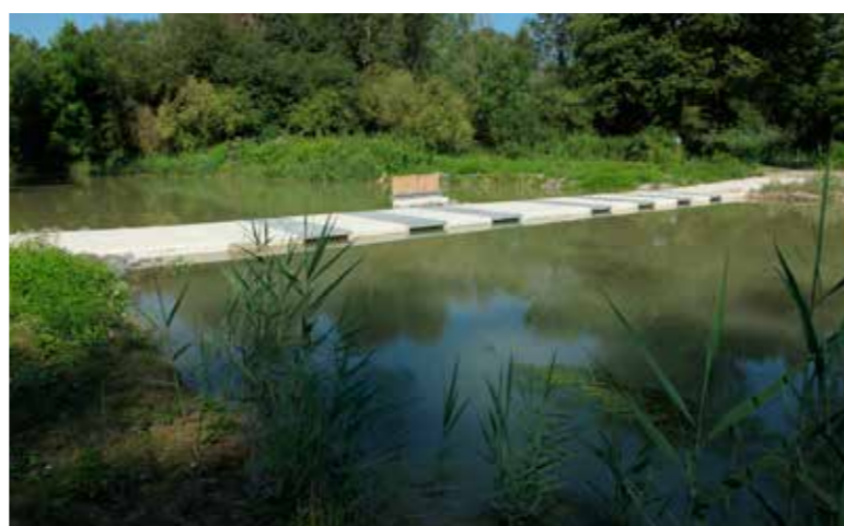
Ouvrage de connexion après les travaux
