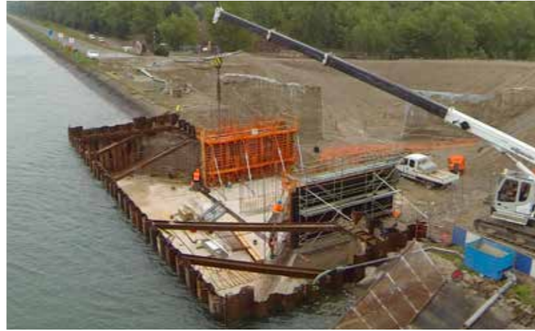
Chantier de la prise d'eau
