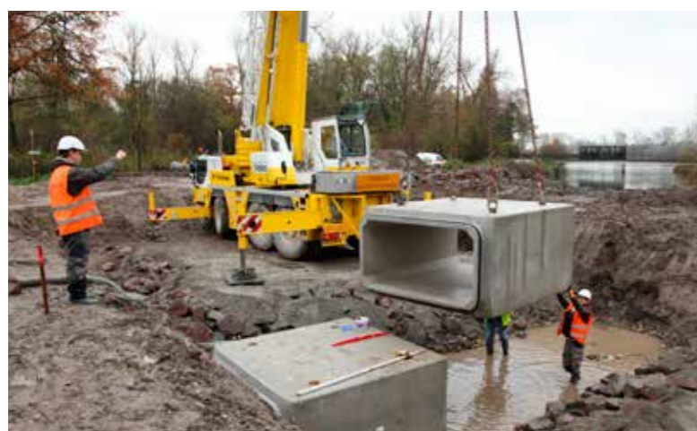
Mise en place de l'ouvrage
